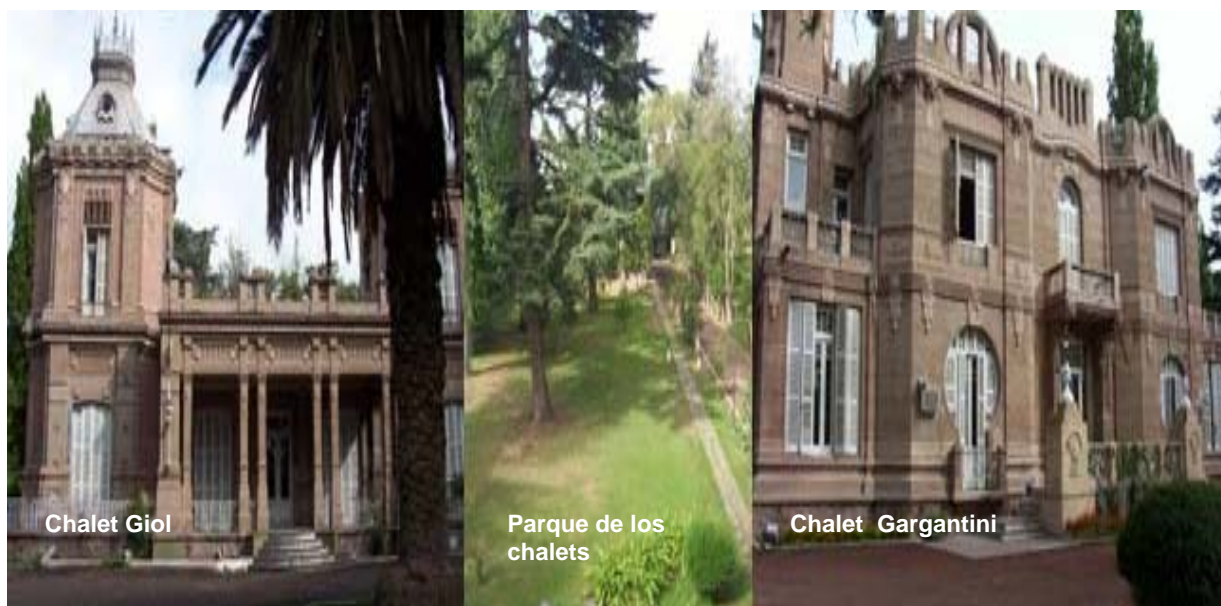
Figura 14 Casonas patronales del establecimiento vitivinícola de bodega Giol
