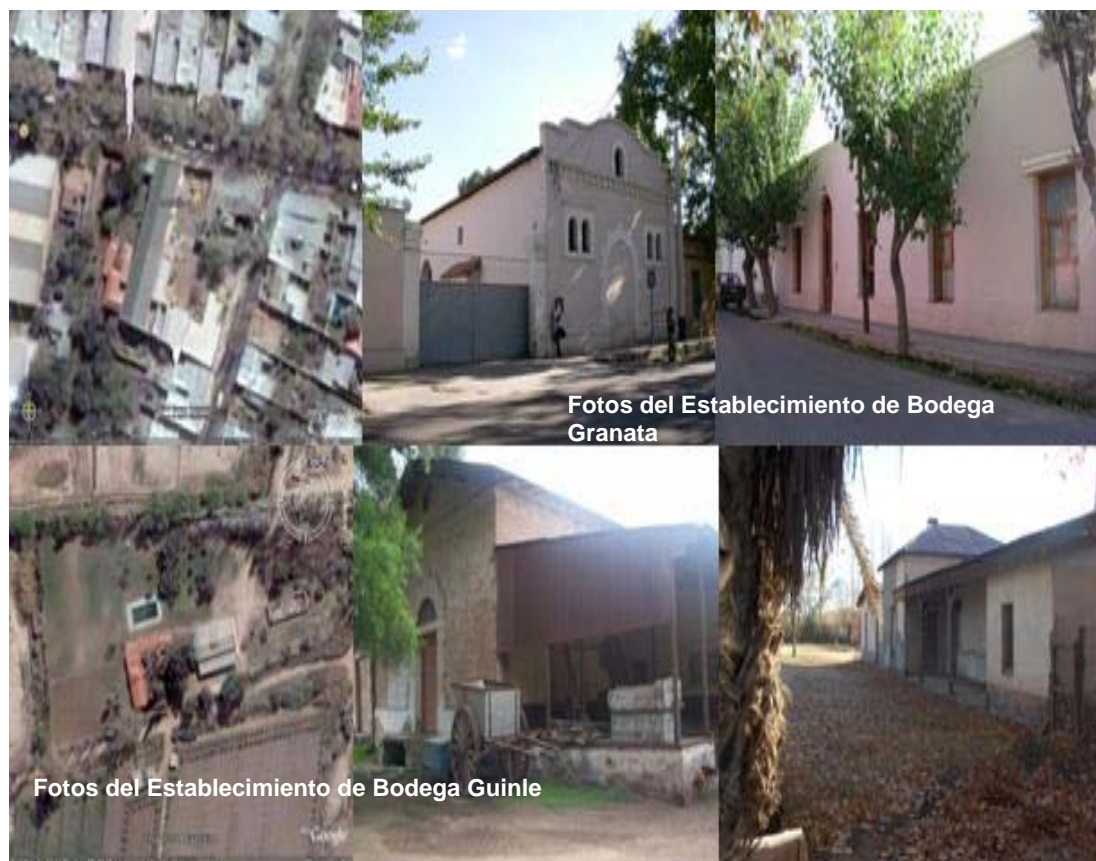
Figura 10 Establecimientos con bodega de una nave productiva
